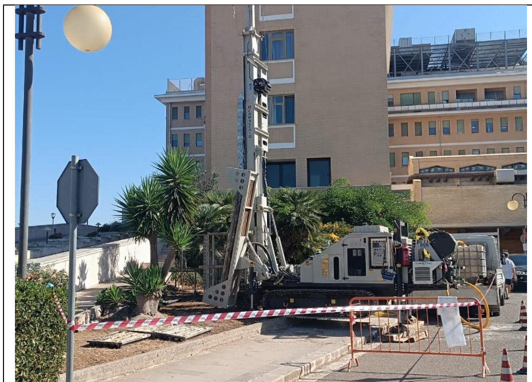
Esecuzione sondaggio S3
